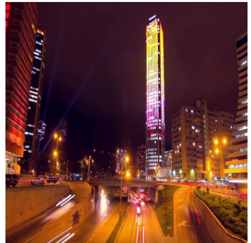
Torre Colpatria: Lighting Phillips
