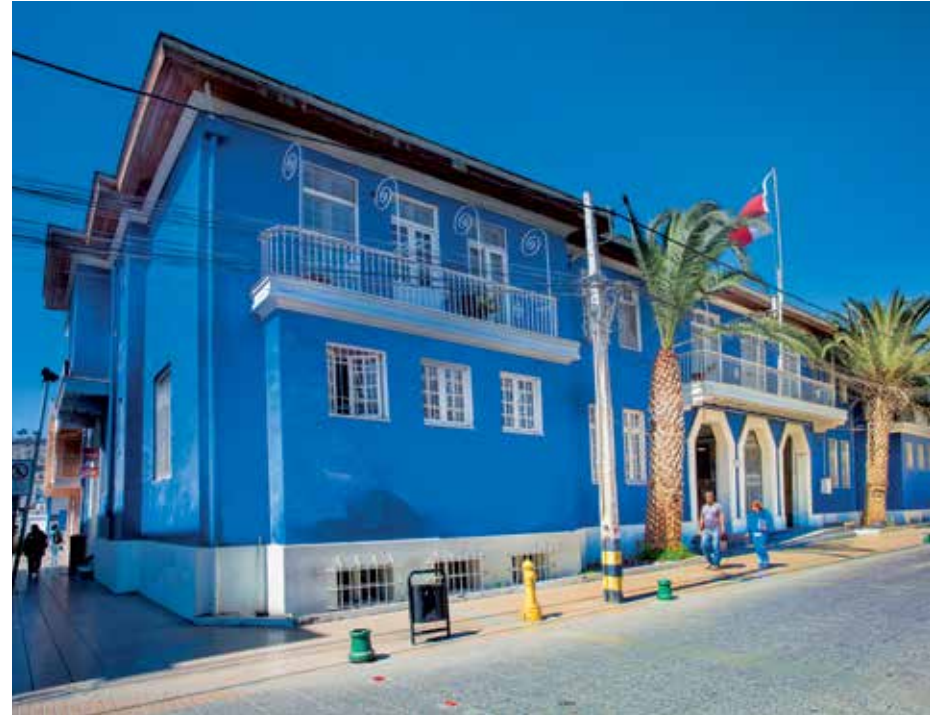
Edificio Gobernación de Huasco, Vallenar.
